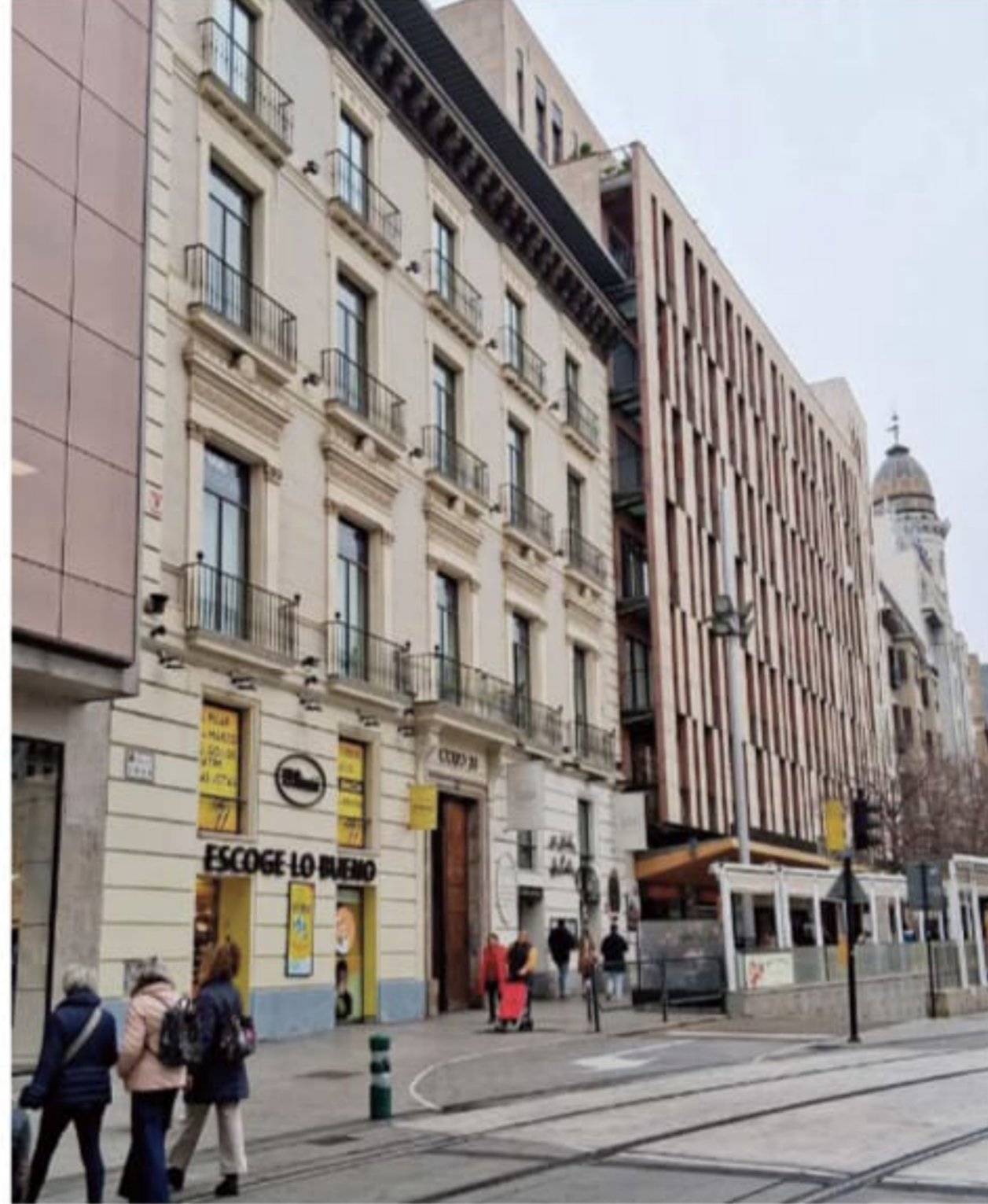
Edificio que alberga la sede de Forestalia en el Coso 33 de Zaragoza
